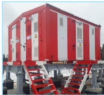
ЗапСибНефтехим Тобольский аэропорт
