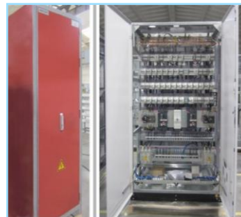
Газпром ПХГ Калининградское ПХГ
