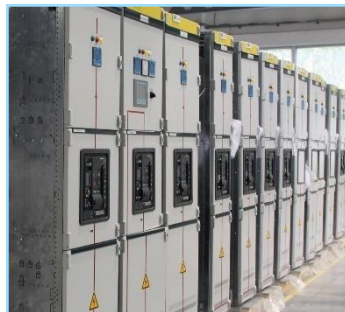
ЗапСибНефтехим Сибур Тобольск
