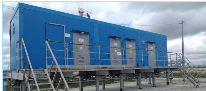
Газпром Переработка Завод по подготовке конденсата к транспорту
