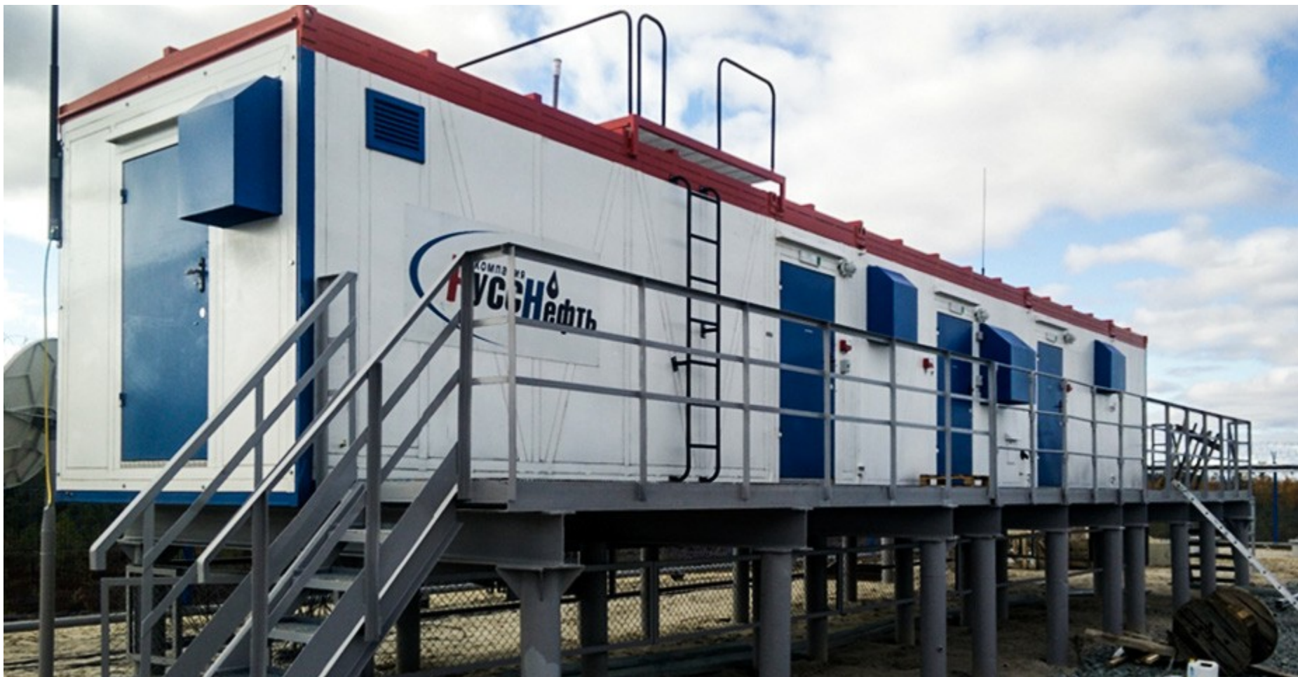
Автономный энергокомплекс «ЭНЕРГО-K18M3.3.G40-6/3» Место эксплуатации: Ханты-Мансийский АО Область применения: для бесперебойного электроснабжения технологического оборудования трубопровода
