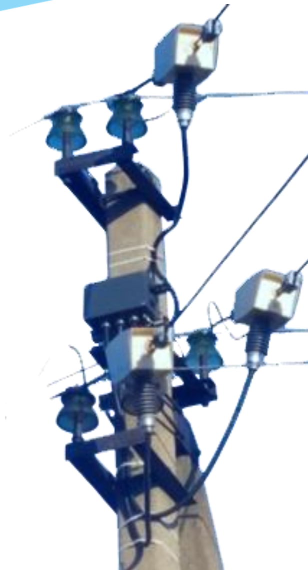
Не инвазивная установка на ВЛЭП 6(10) кВ
